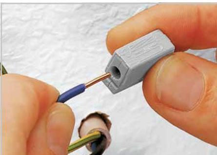
Leiter anschließen (Installationsseite):
