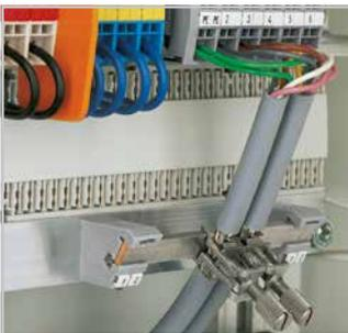
Montage auf Sammelschiene mit Halteböcken
