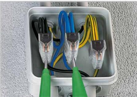
Spannungsprüfung in separater Prüfföpfung
